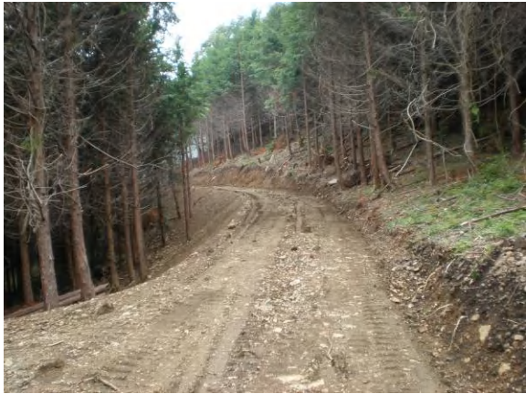
整備された作業道
