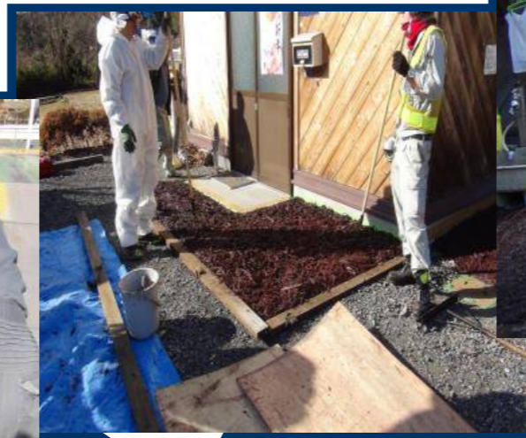
3 敷均し・転圧
